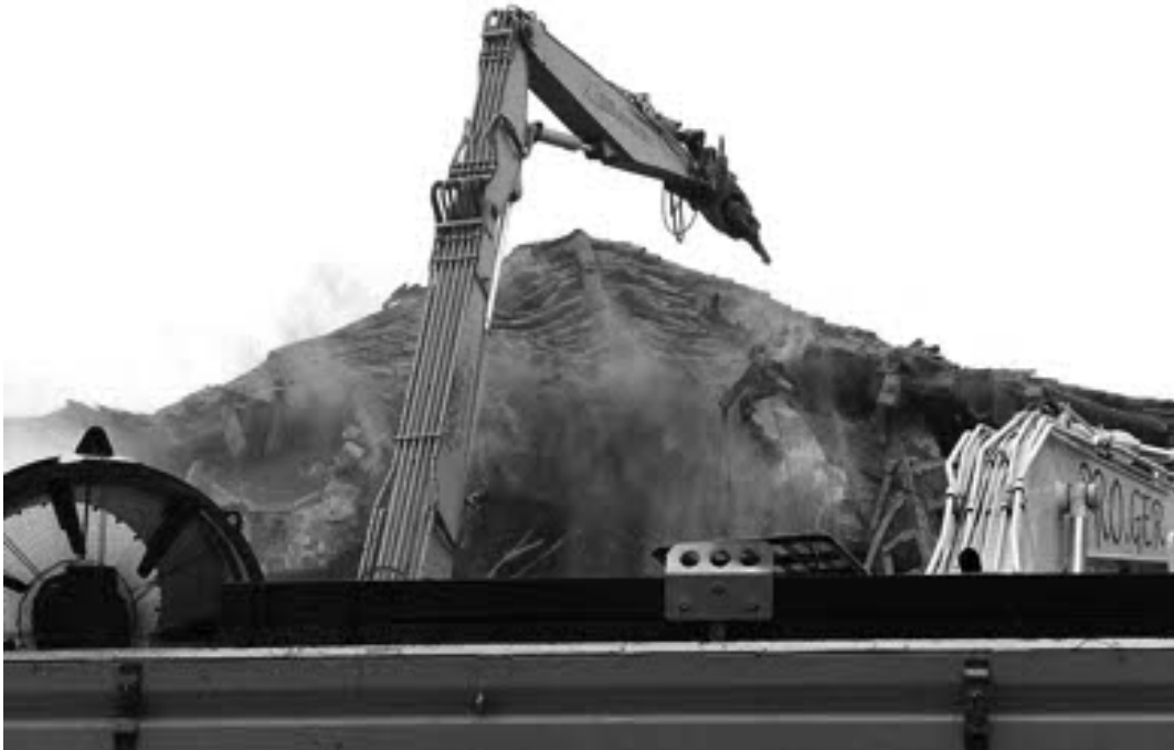
La ruspa della ditta incaricata dei lavori abbatte anche l'ultima arcata: il vecchio cinema è arrivato all'ultimo atto
