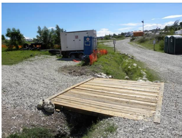
Ponte sul canale di scolo
