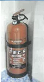
Estintore: fornitura di un estintore da 2 kg, completo di alloggiamento.
